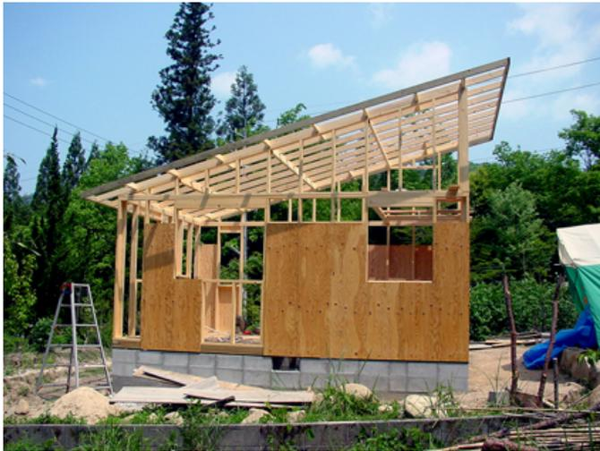
屋根の両端の部分破風と言います、その斜辺に付ける、蠅羽垂木の端を隠す飾り板を破風板という。
