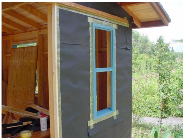
コーキング (caulking)：窓枠の周囲、部材の接ぎ目などの小さいすき間にバテ状の充填材を詰めること。また、その充填材。
